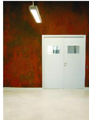
Vera Ruggine su muratura
